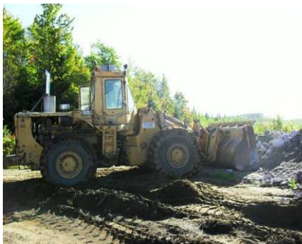
Le matériel lourd est sur place pour effectuer les travaux dans ce secteur sous les lignes d'Hydro-Québec du sentier TQ-60.
